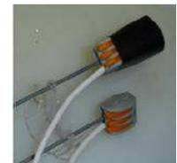
Umleitung: verwenden Sie das freie Loch um das Kabel einzureihen.
