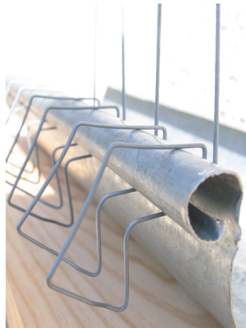
Richtig angebracht! Klipp ist unter der Kante.
