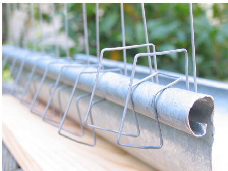
Falsch angebracht! Klipp muss unter die Dachrinnenkante.
