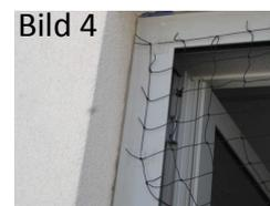
Wann ? : Wenn eine Stelle durch Vögel mit schwachem, mittelmäßigem oder starkem Druck belastet ist. **Achtung: die Wahl der Maschenweite (19, 28 oder 50 mm) hängt von der Vogelart ab.**
