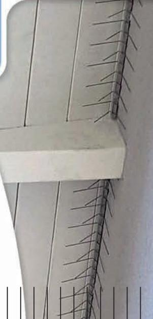
Die Spitzen werden am seitlichen Rahmen der Module einfach mit Silikonkleber angebracht.
